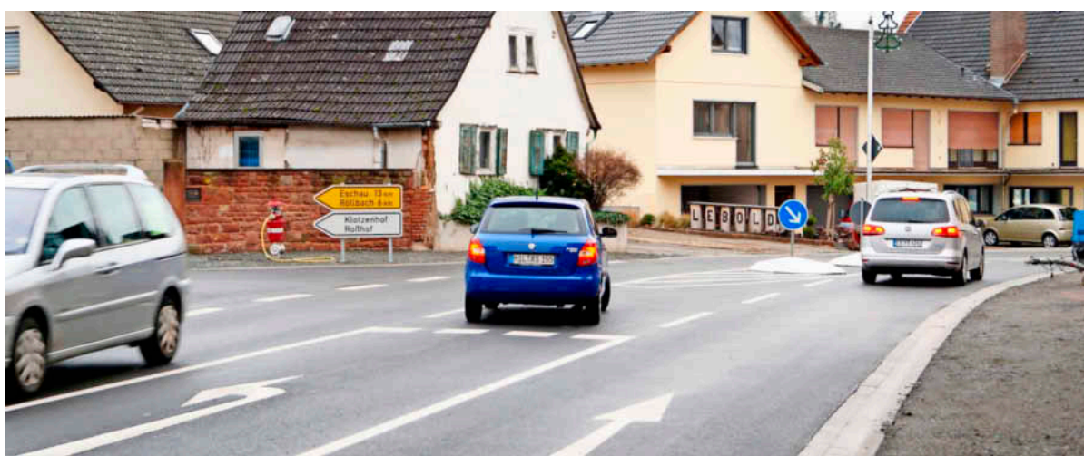
Die Großheubacher Ortsdurchfahrt ist seit Mittwoch wieder für den Verkehr freigegeben.
